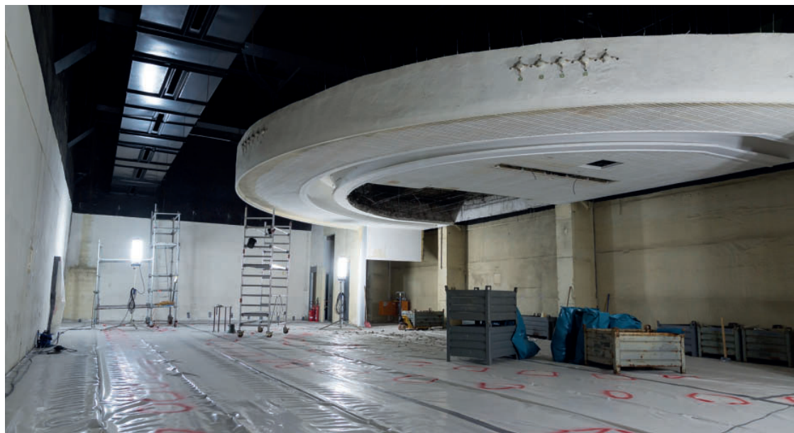
Die Blockwarte 2 wurde vollständig demontiert.
