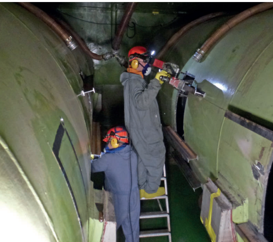
Zwei Spülwasserbehälter der ehemaligen Verdampferanlage werden demontiert.
