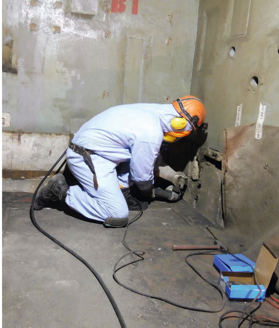
Heraustrennen der metallischen Raumauskleidungen
