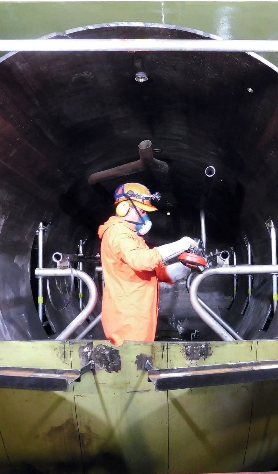
Zerlegung der Spülwasserbehälter (je 13,5 t)
