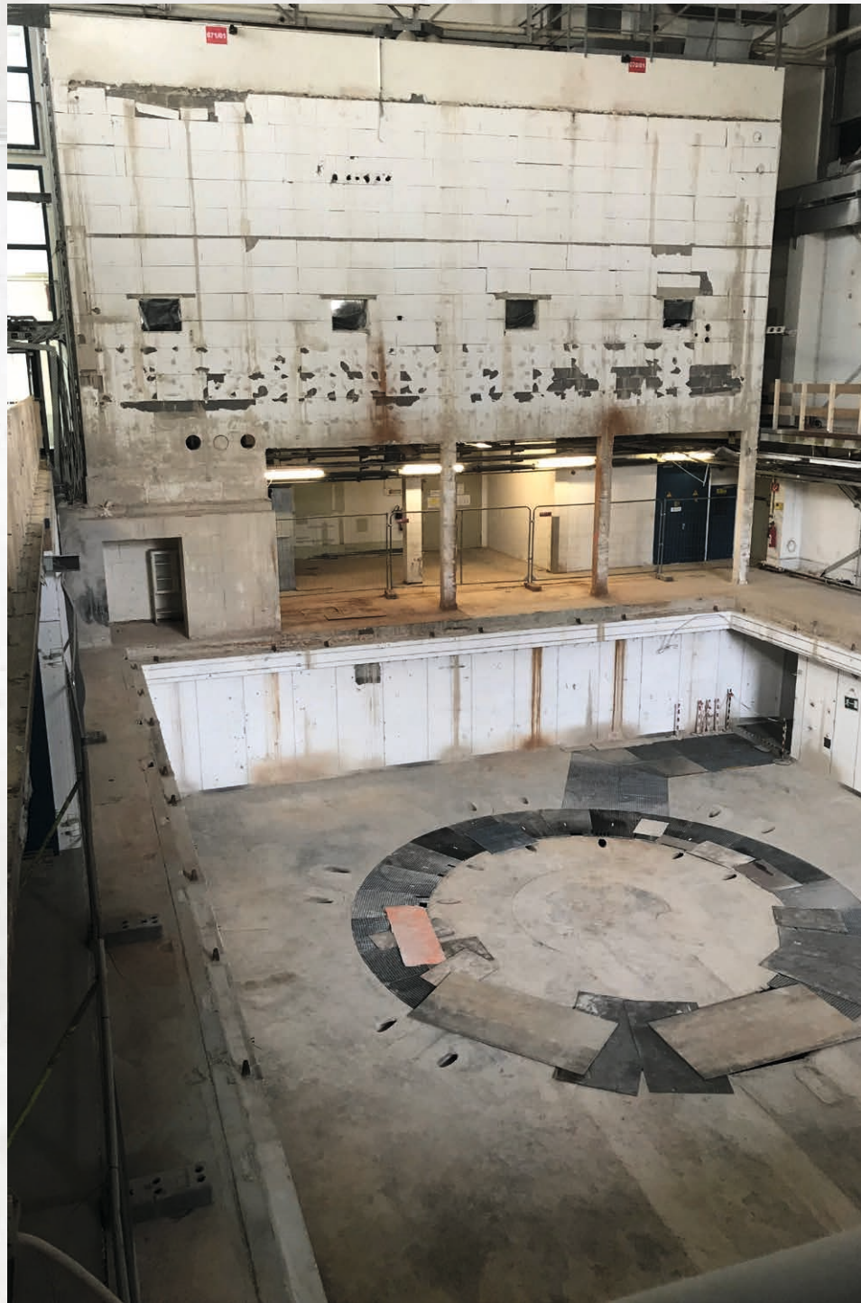
Blick in die leere Projekthalle. Projekt TEXTOR ist beendet.
