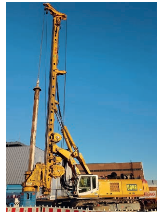
Bohrergerät zur Herstellung der Bohrpfähle
