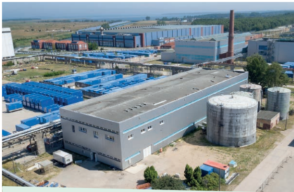
Fassadenerneuerung der CWA
