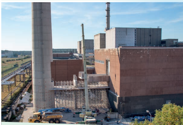
Demontage PE 302 am Kamin 2
