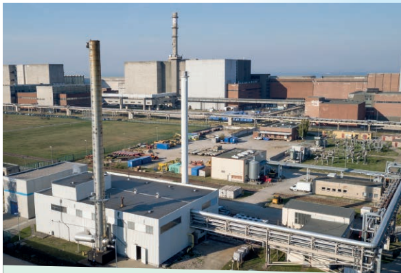
BHKW und HWVA
