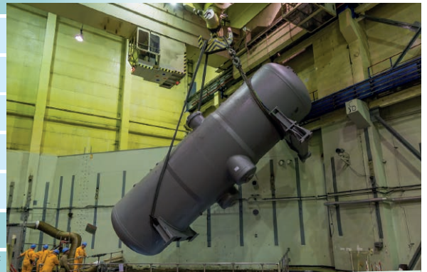
Dampfzeugertransport zum Zerlegeplatz in die Box Block 4
