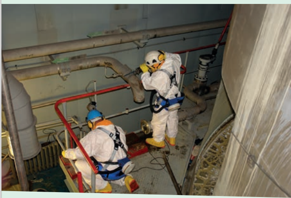
Zerlegung EDR-Behälter im GSG
