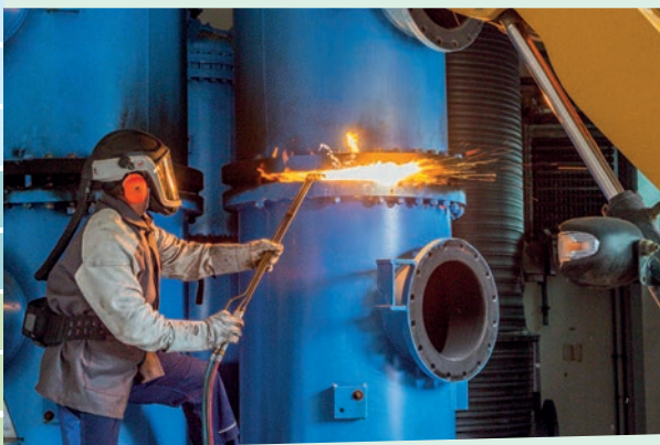
Demontage von Ausrüstungen in der CWA
