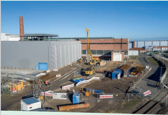
Bohrpfahlgründung für die Zerlegehalle
