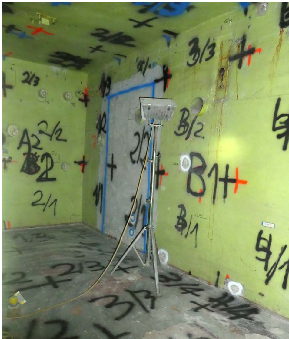
Die geplante Wandöffnung (blauer Rahmen) nach dem Fräsen und der Durchführung der radiologischen Messungen
