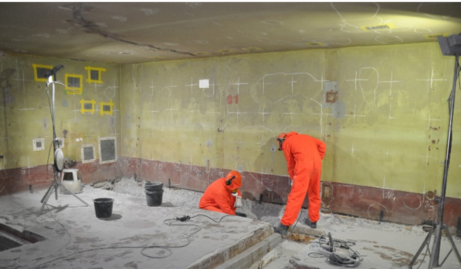
Arbeiten im Kontrollbereich des KKR
