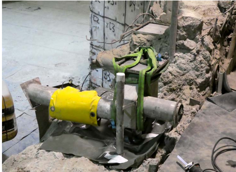
Angeschlagener Ventilsumpf vor dem Herausheben aus der Einbaulage
