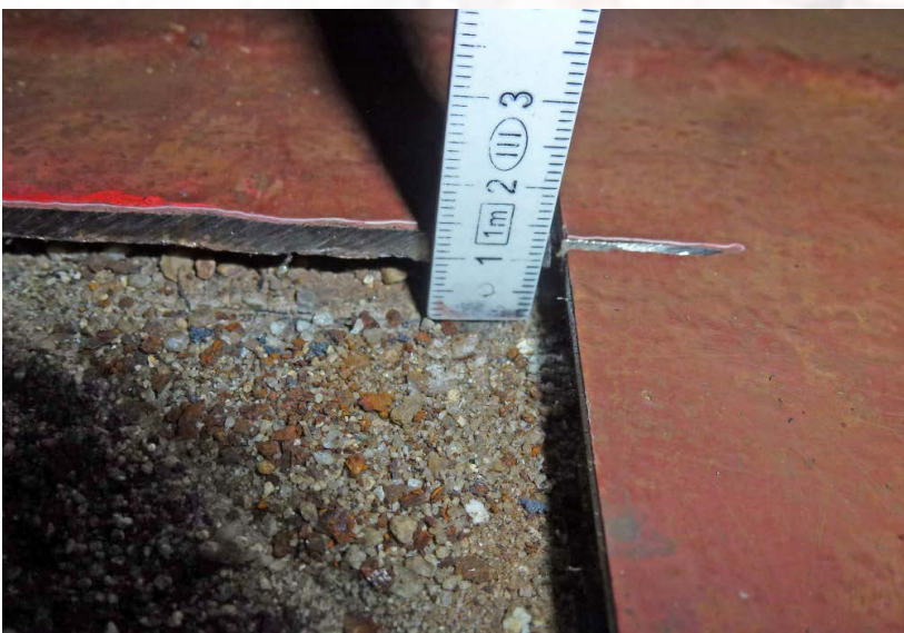
Fenster im Eingangsbereich R 209c mit WOFATIT-Kugeln
