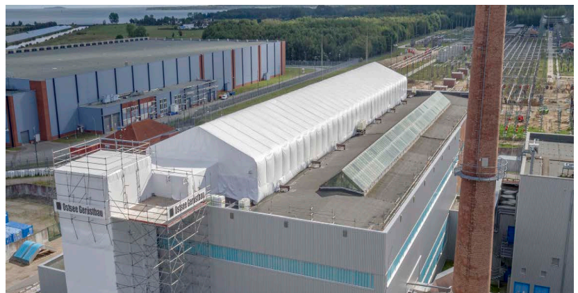
Arbeiten am Dach der ZAW
