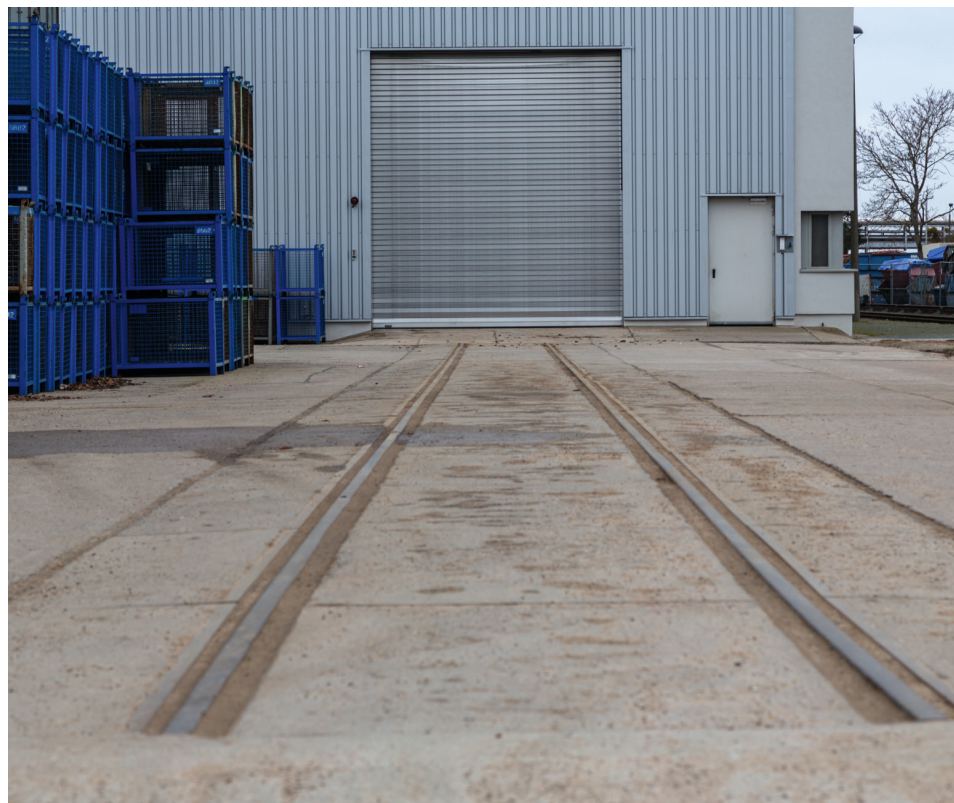
Gleis A2 vor der Einfahrt zur FMA
