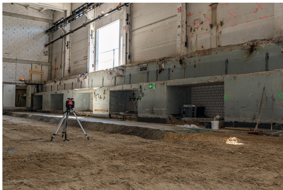
Entkernungsarbeiten in der ZSA
