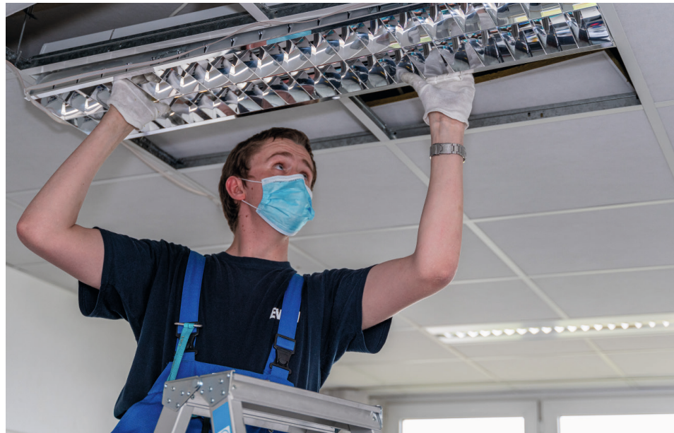
Austausch der Beleuchtung im Verwaltungsgebäude
