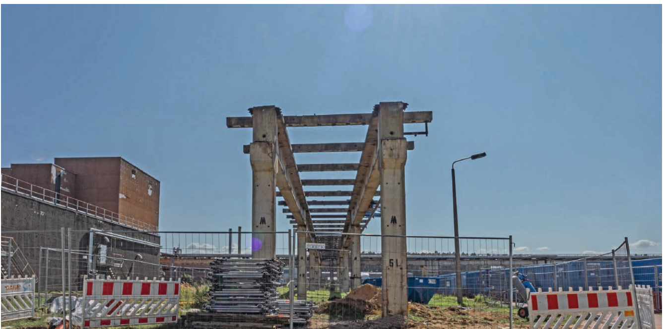
Abriss der Rohrbrücke M
