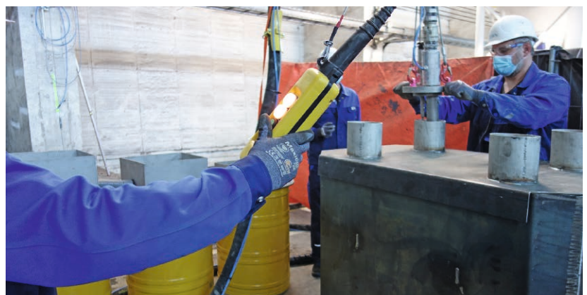
Verfüllen eines Konrad-Container-Nachbaus
