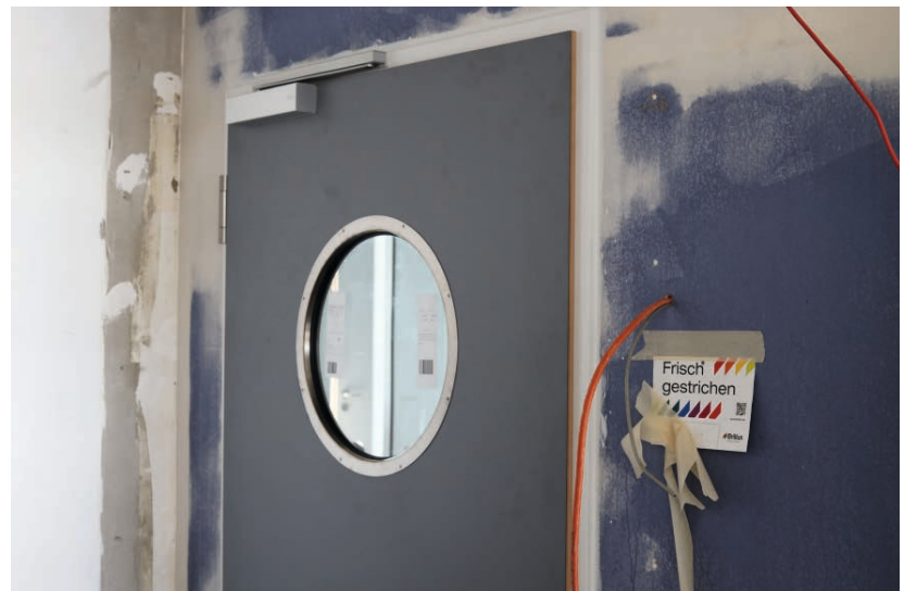
Endspurt für die Umbauarbeiten im August 2021
