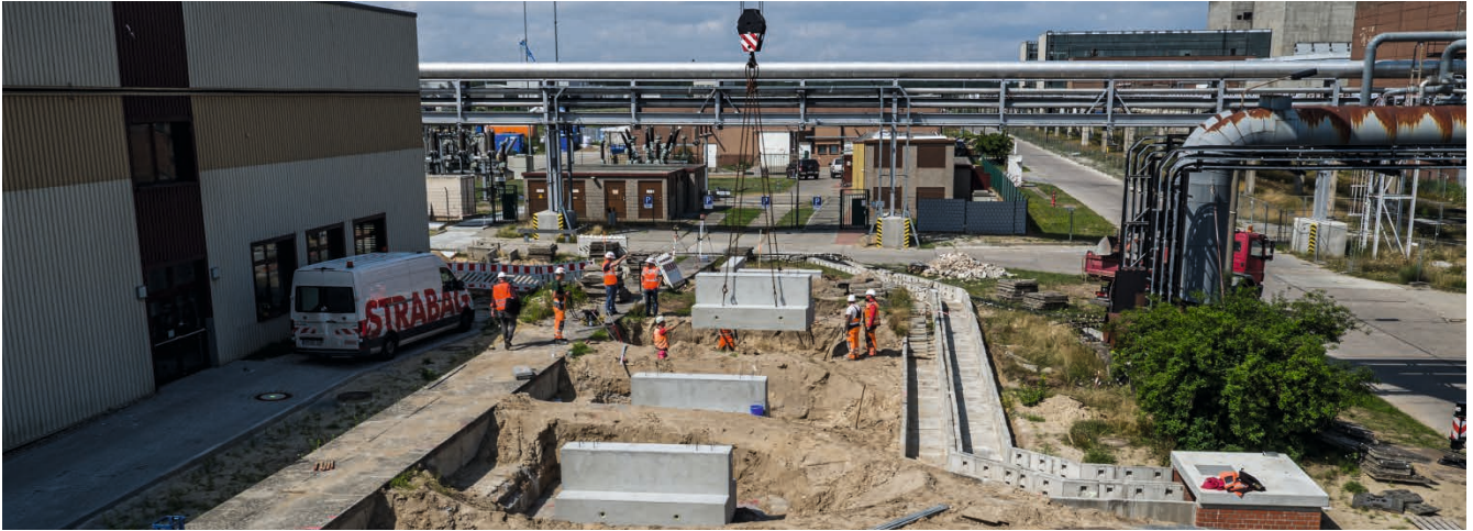
Errichtung einer neuen Medientrasse
