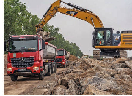
Abtransport des Betons zur EWN-Brecheranlage
