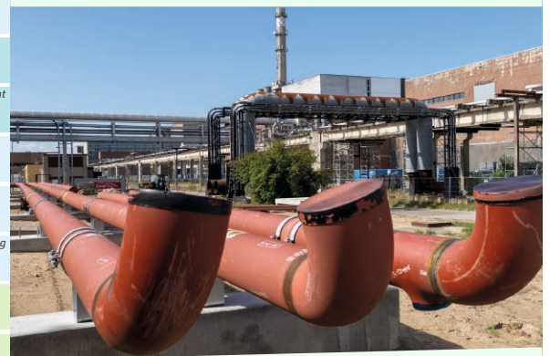
Errichtung neuer Medientrassen
