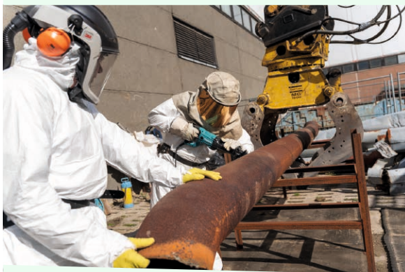
Zerlegearbeiten vor dem SaniLab 2
