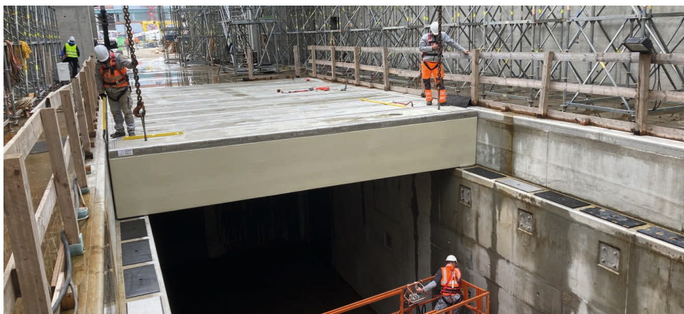
Bau der Kranbahnkonsolen in der Zerlegehalle
