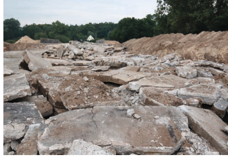
Eine Menge von ca. 6.000 Tonnen Beton musste entsorgt werden.
