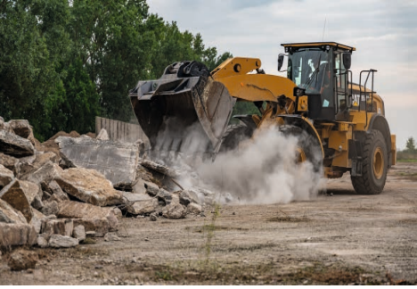
Mit schwerem Gerät begannen ab September die Rückbauarbeiten.
