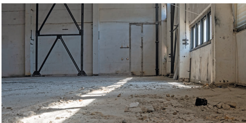
Umbauarbeiten des Gebäudes der ZSA zu einem Verwaltungs- und Betriebskomplex
