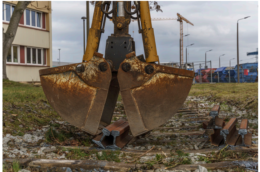
Demontage der Gleise vor dem Verwaltungsgebäude 1
