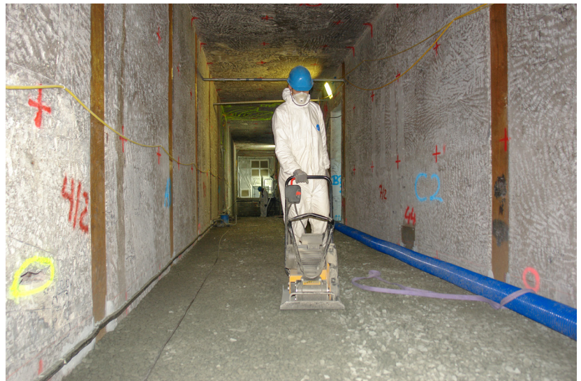
Einbringen einer verdichtungsfähigen Splittschüttung auf dem Fußboden im SG1
