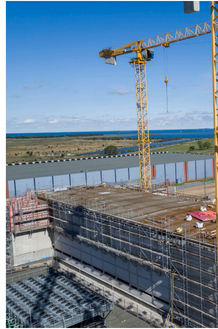
Blick auf die Zerlegehalle
