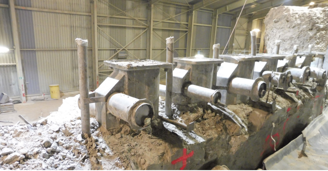
Freigestemte Sylphonventile im ALfR (2021)
