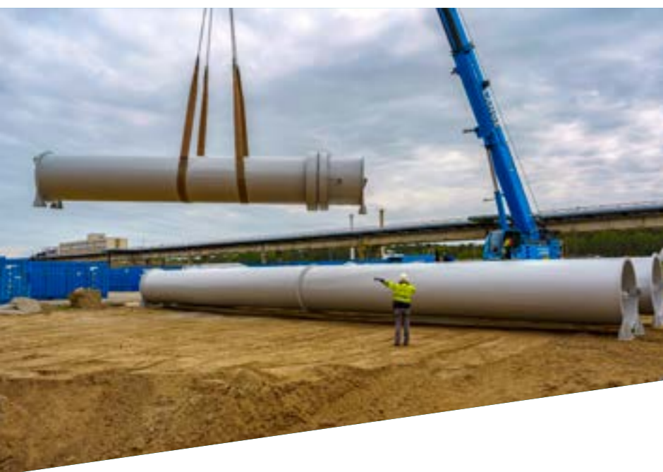
Anlieferung des Kamins der Externen Abluftanlage
