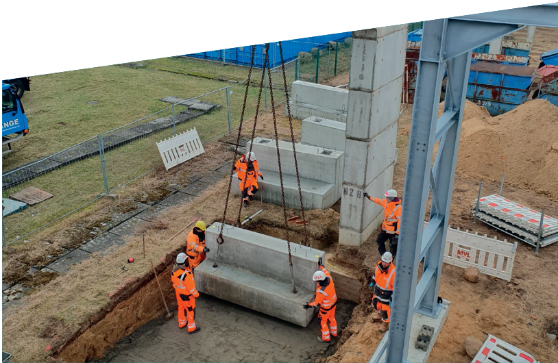
Montage der Fundamente für die neue Medientrasse
