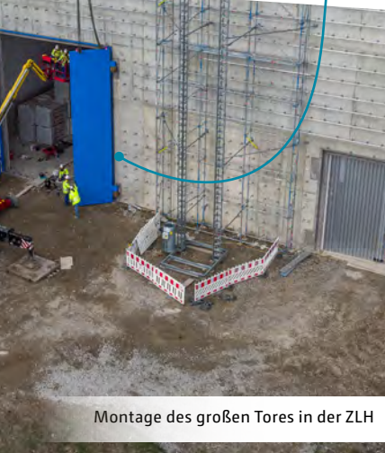
Alles im Lot: Der Kamin der externen Abluftanlage steht
