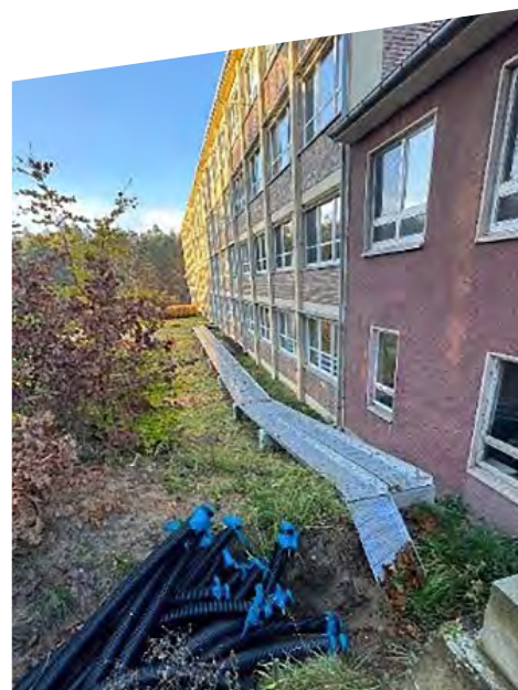
Oberirdische Blechwannenkabeltrasse
