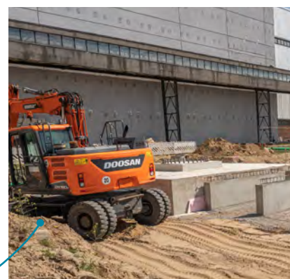
Neues Fundament für die Externe Abluftanlage
