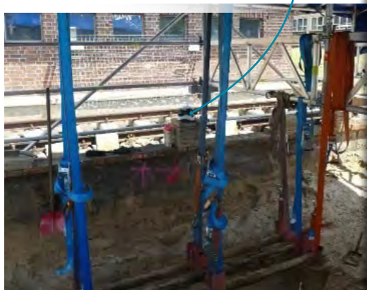
Gesicherte Öldruckkabel
