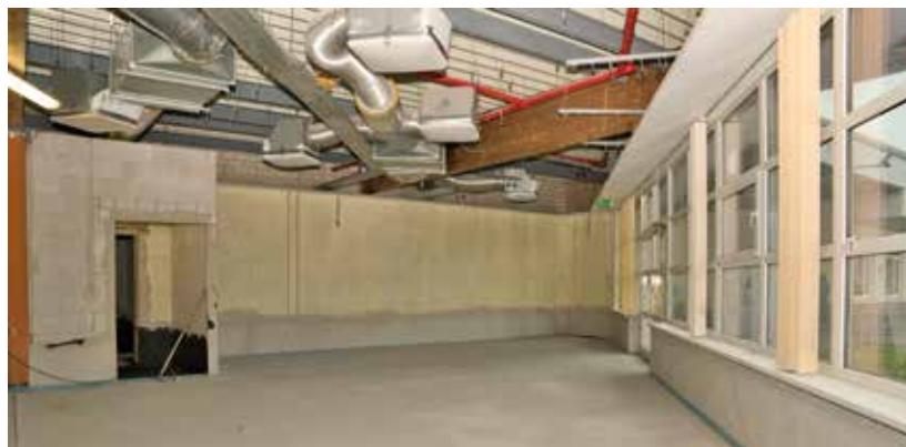
Die Fortschritte in der Kantine sind nun deutlich sichtbar
