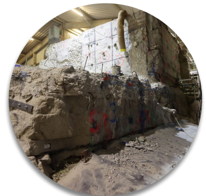
Sicherung des Betonbruchstückes durch Verankerungen
