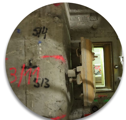
Blick auf die Strahlenschutztür des zurückzubauenden Raumes R 017
