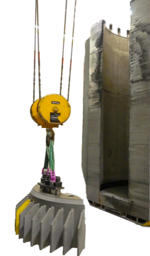
TK C30-Vorzerlegung im Caisson 3
