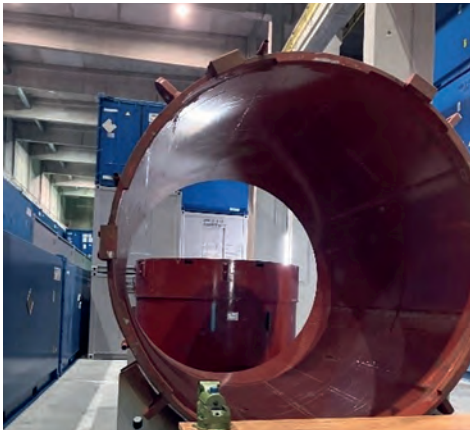
Vorbereitung für die Zerlegung der Reaktorschutzcontainer
