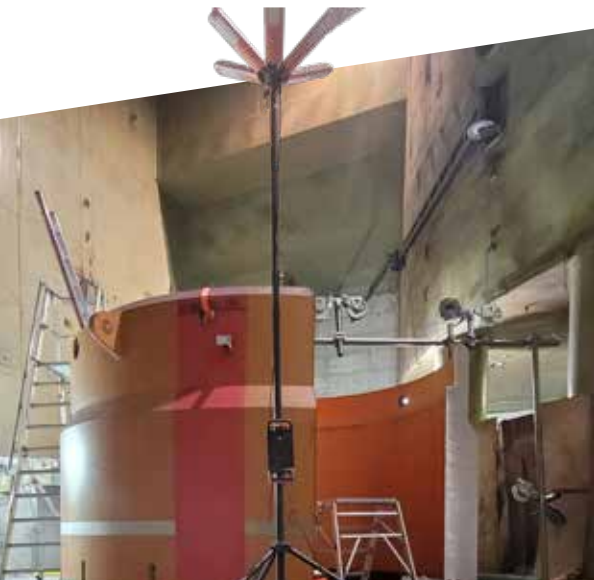
Teilerlegter Reaktorschutzcontainer auf dem AS 6 im Block 4.
