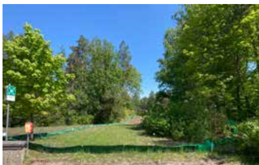
Errichtung eines Reptilienschutzzaunes
