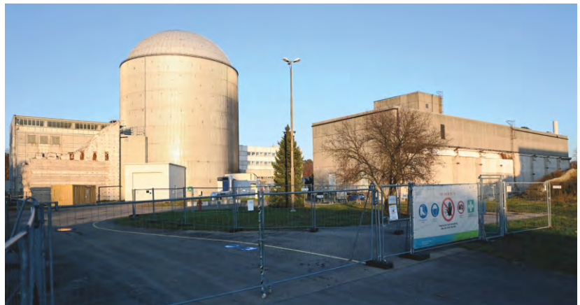
Blick auf die Kuppel des MZFR mit angrenzenden Nebengebäuden
