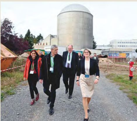
Besichtigungstour zum Rückbauprojekt MZFR.
