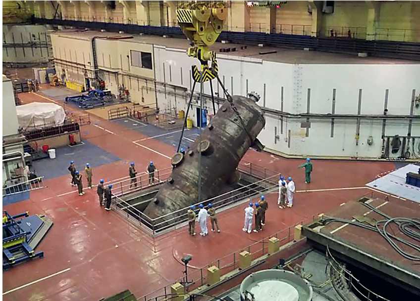
Demontage eines Dampferzeugers aus dem Block 3
