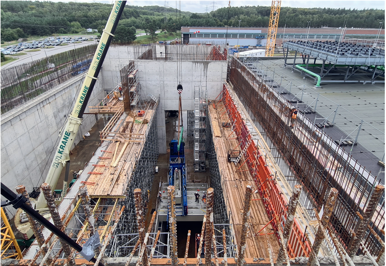
Die Betonwände wachsen in die Höhe, während die Zerlegegrube mit Betonträgern abgedeckt wird
