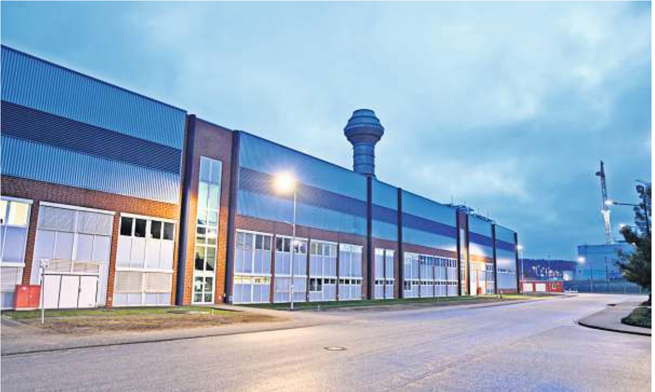
Bild: Das Zwischenlager Nord auf dem Gelände des Entsorgungswerks für Nuklearanlagen am Standort des ehemaligen Kernkraftwerks Lubmin.
