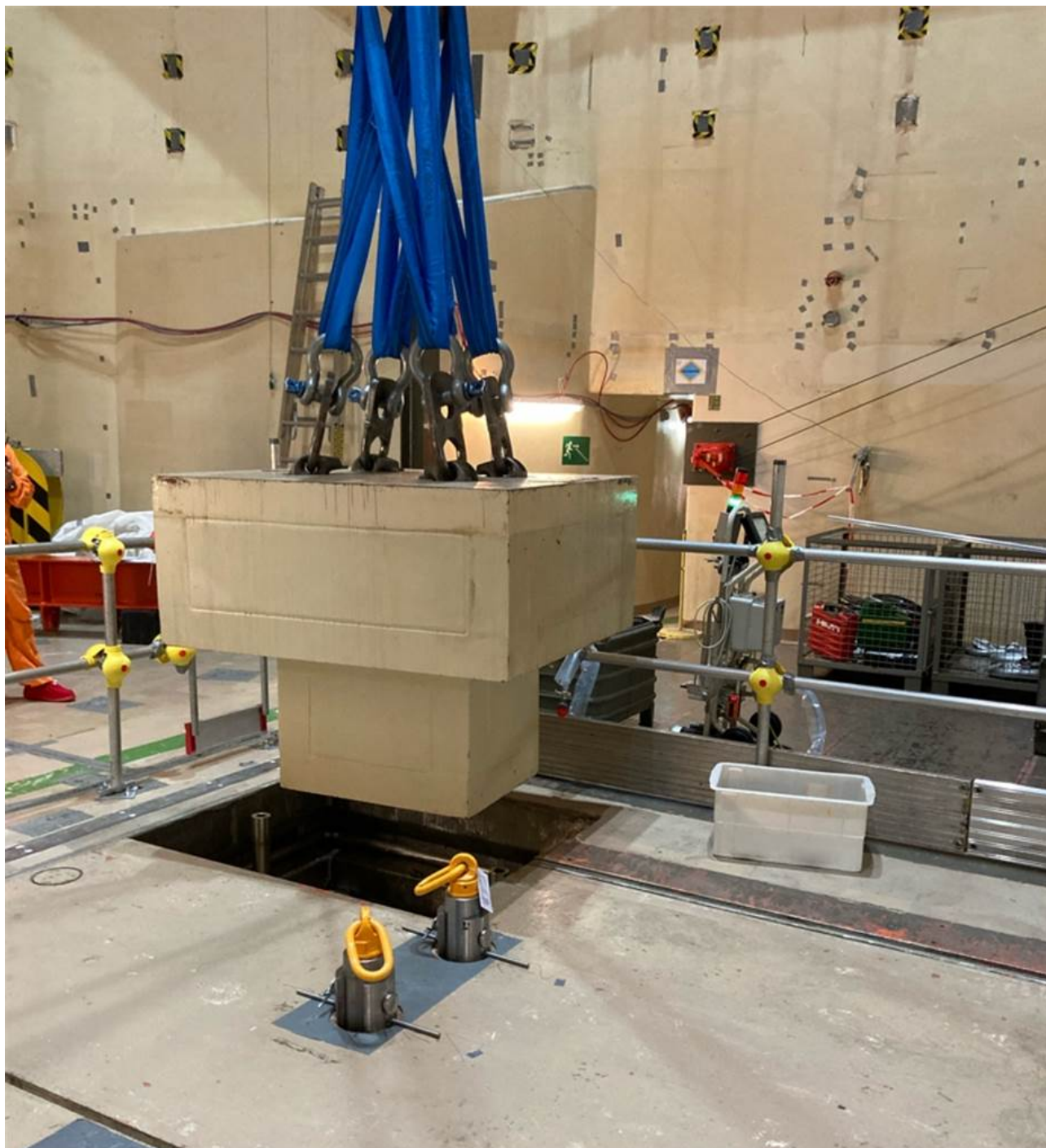
Bild: Heben des ersten Betonriegels.
