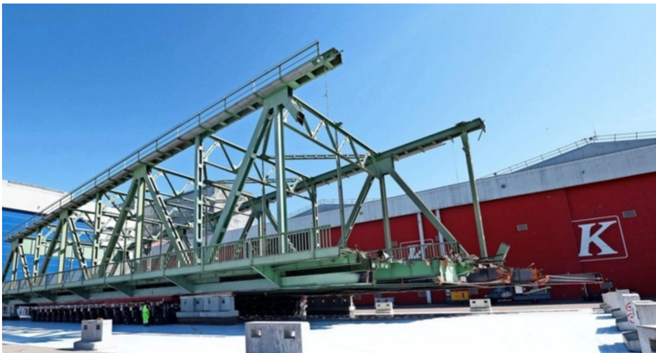
Bild: Havarierte Eisenbahndrehbrücke wird in Lubmin zerlegt .
