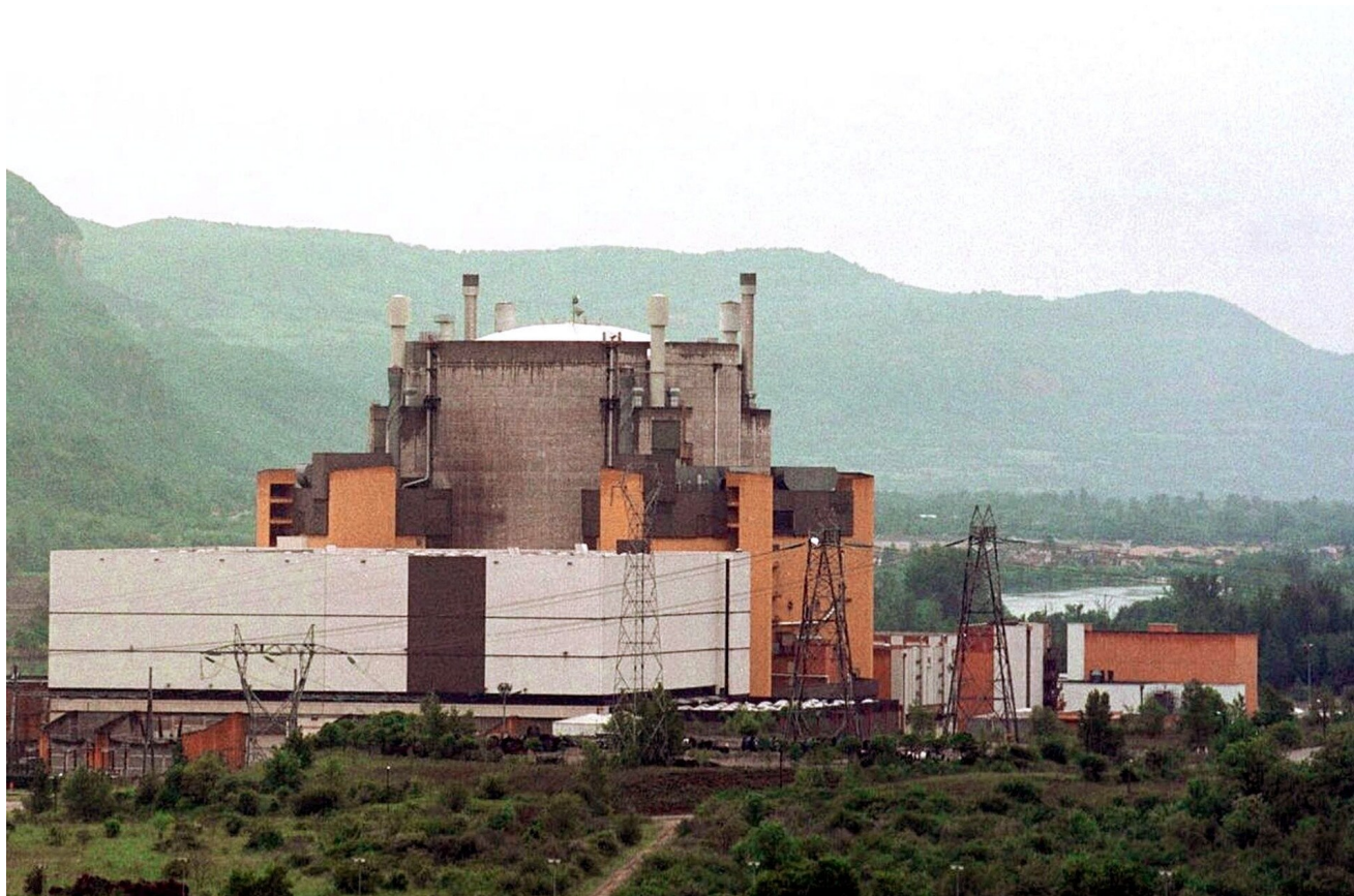
Bild: Archivbild des Atomkraftwerks Superphénix mit schnellem natriumgekühlten Brutreaktor in Crey-Malviulle, Frankreich. Wegen technischer Probleme wurde die Anlage wieder stillgelegt.
