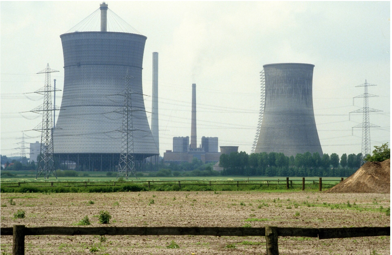
Bild: Archivbild des Thorium Hochtemperaturreaktors THTR 300 in Hamm-Uentrop: Der kommerzielle Betrieb des mit Helium gekühlten Reaktors wurde wegen vieler technischer Probleme schon nach kurzer Zeit wieder eingestellt.
