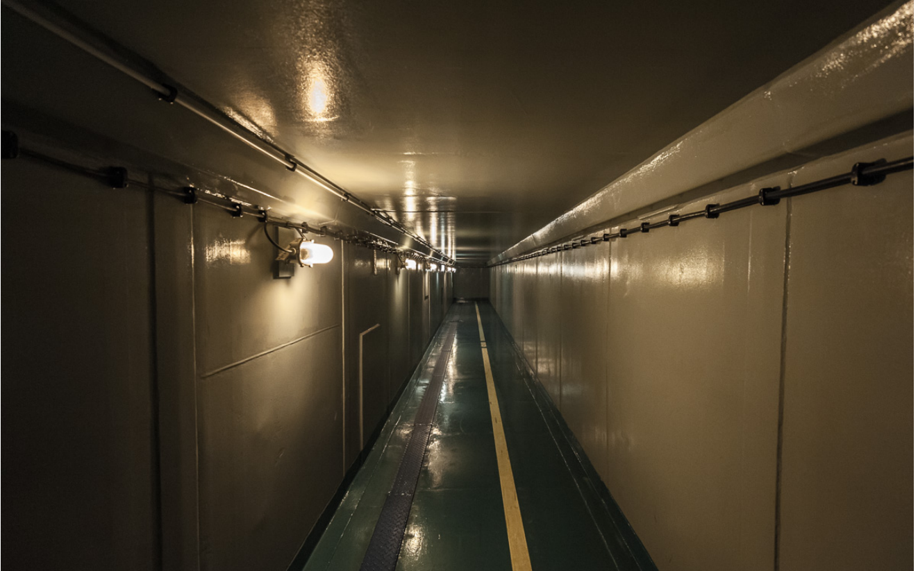
Lange und spärlich beleuchtete Flure mit Leuchtstreifen auf dem Boden erzeugen eine eigenwillige Atmosphäre.
