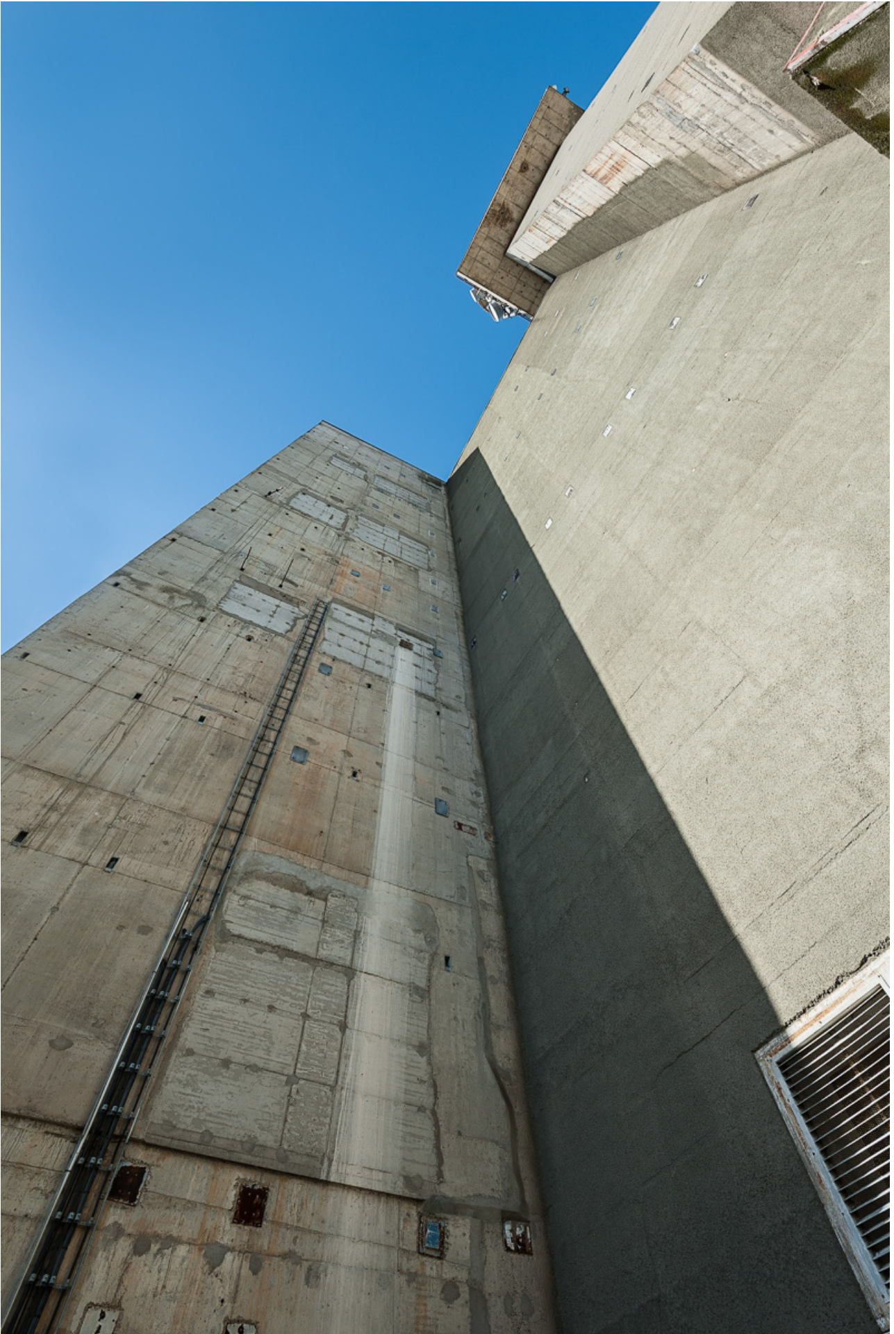
AKW Lubmin: Vor dem Eingang zu Block 6.
