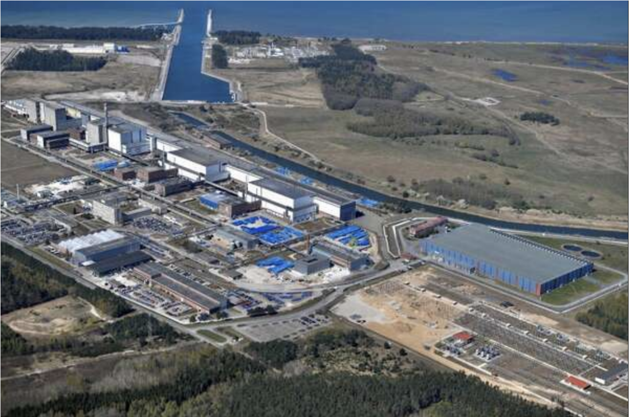
Bild: Das Gelände der Lubminer Entsorgungswerk für Nuklearanlagen GmbH ist laut Meinung der HH2E-Vertreter der ideale Standort für eine große Wasserstoff-Erzeugungsanlage.
