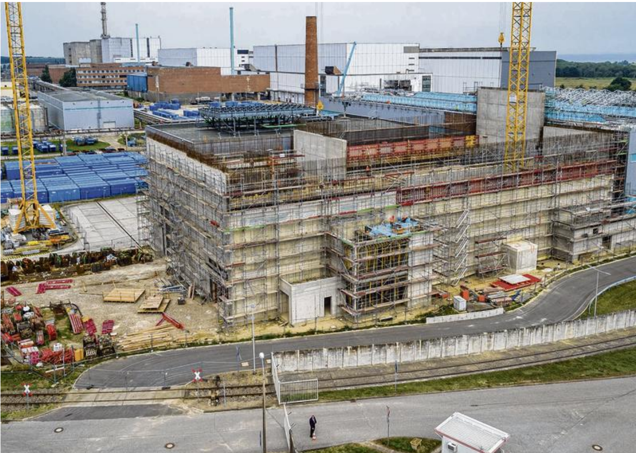
Bild: In Bau befindet sich derzeit die neue Zerlegehalle, die Anfang 2024 in Betrieb gehen soll.
