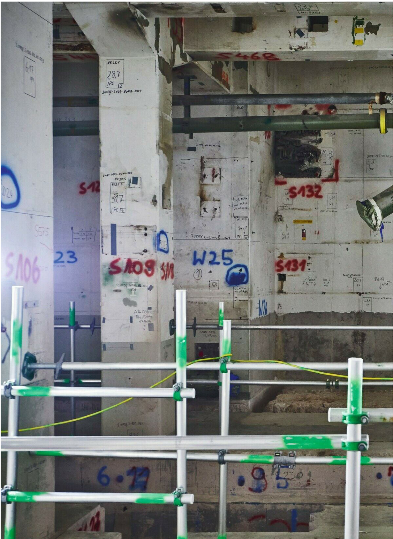
Zahlen an den Wänden zeugen vom Messkataster auf oberflächliche Radioaktivität, das Techniker beim Rückbau für das gesamte Kraftwerksgebäude erstellt haben.
