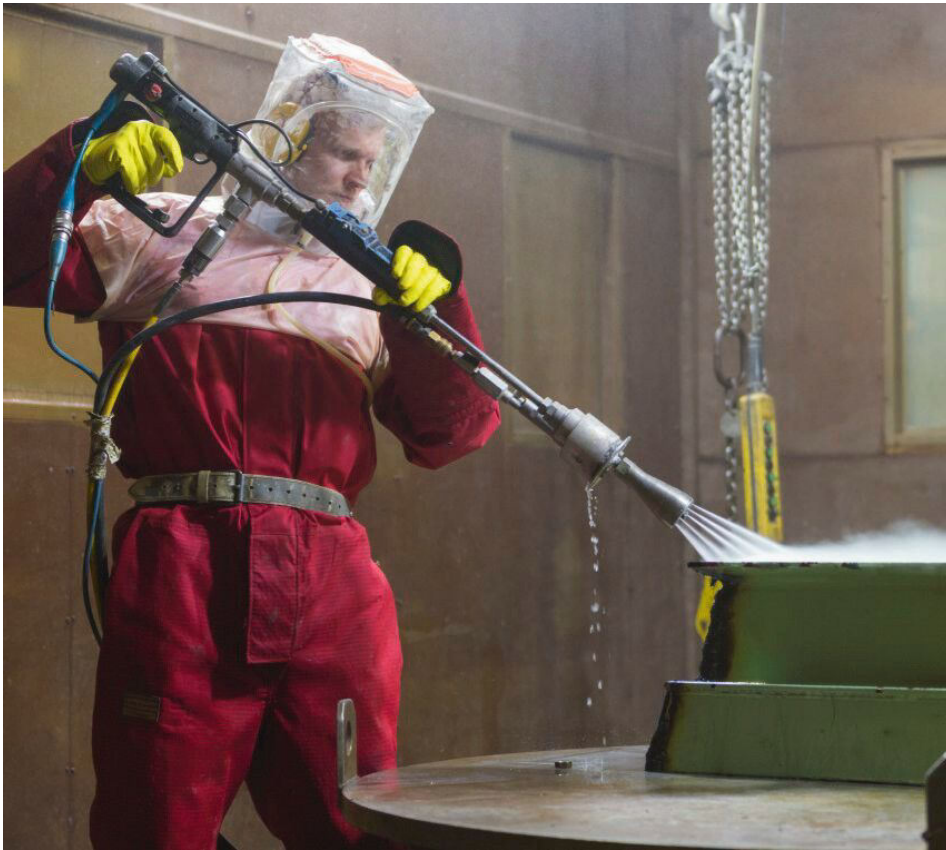
Der Blick in die Maschinenhalle des kurz nach der Wende stillgelegten Kernkraftwerks Lubmin bei Greifswald (oben) zeigt heute unter anderem zahlreiche Behälter, in denen abgebaute, zerkleinerte und gereinigte Kraftwerksteile verpackt werden.
