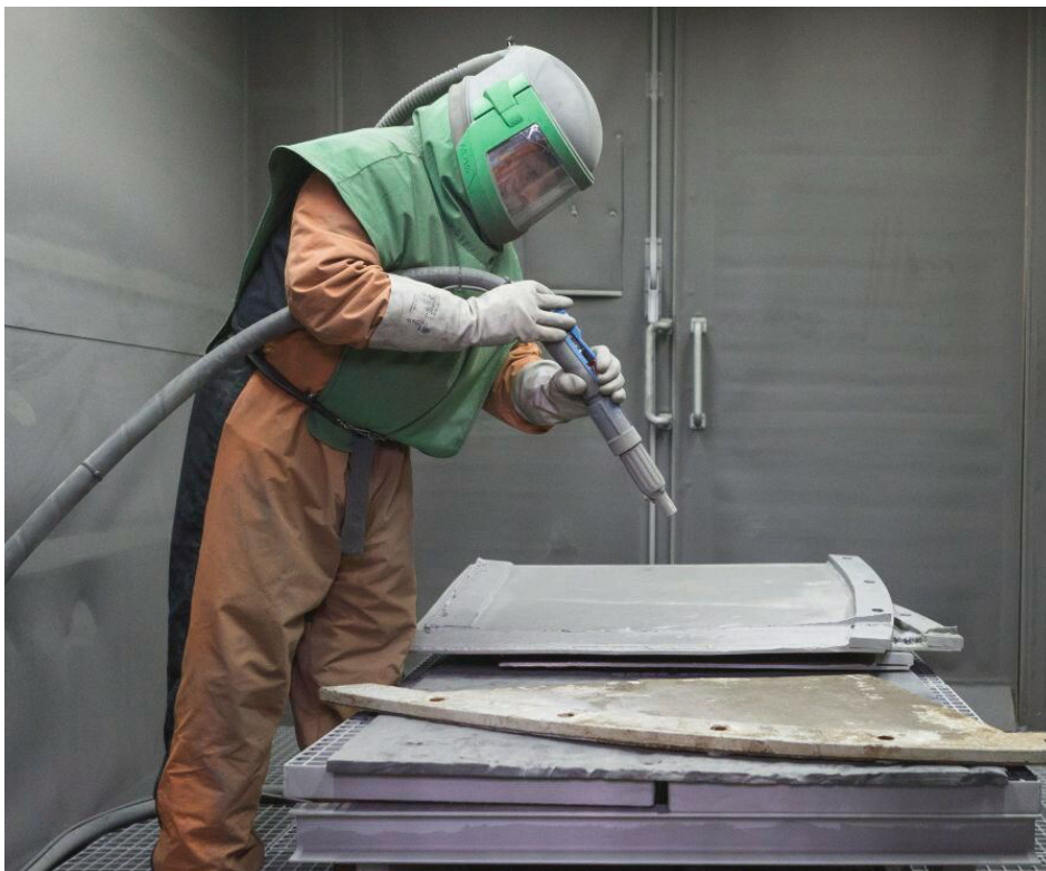
Wenn ein Kernkraftwerk ausgedient hat, beginnt die Arbeit für die Abriss-techniker
