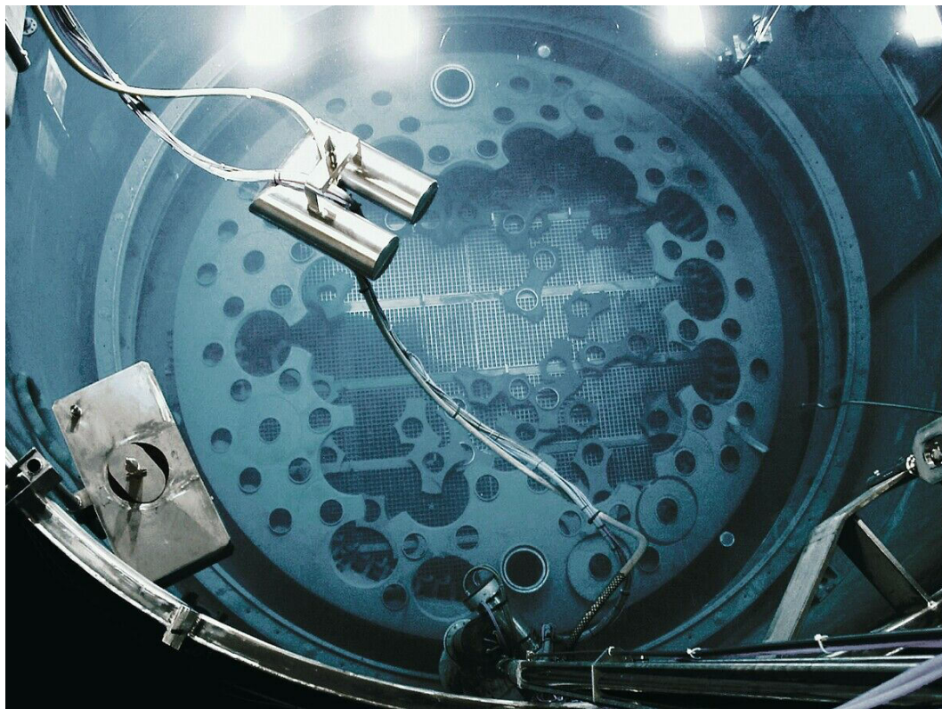
Häppchenweise wird der Reaktorkern per Robotertechnik demontiert.
