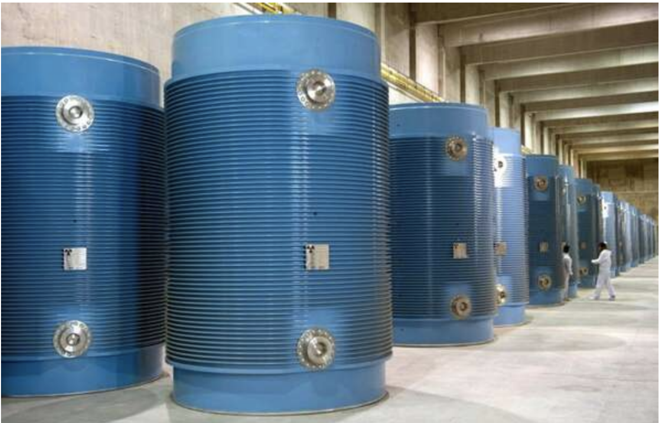
Castorbehälter in Halle 8 des Zwischenlagers Lubmin.
