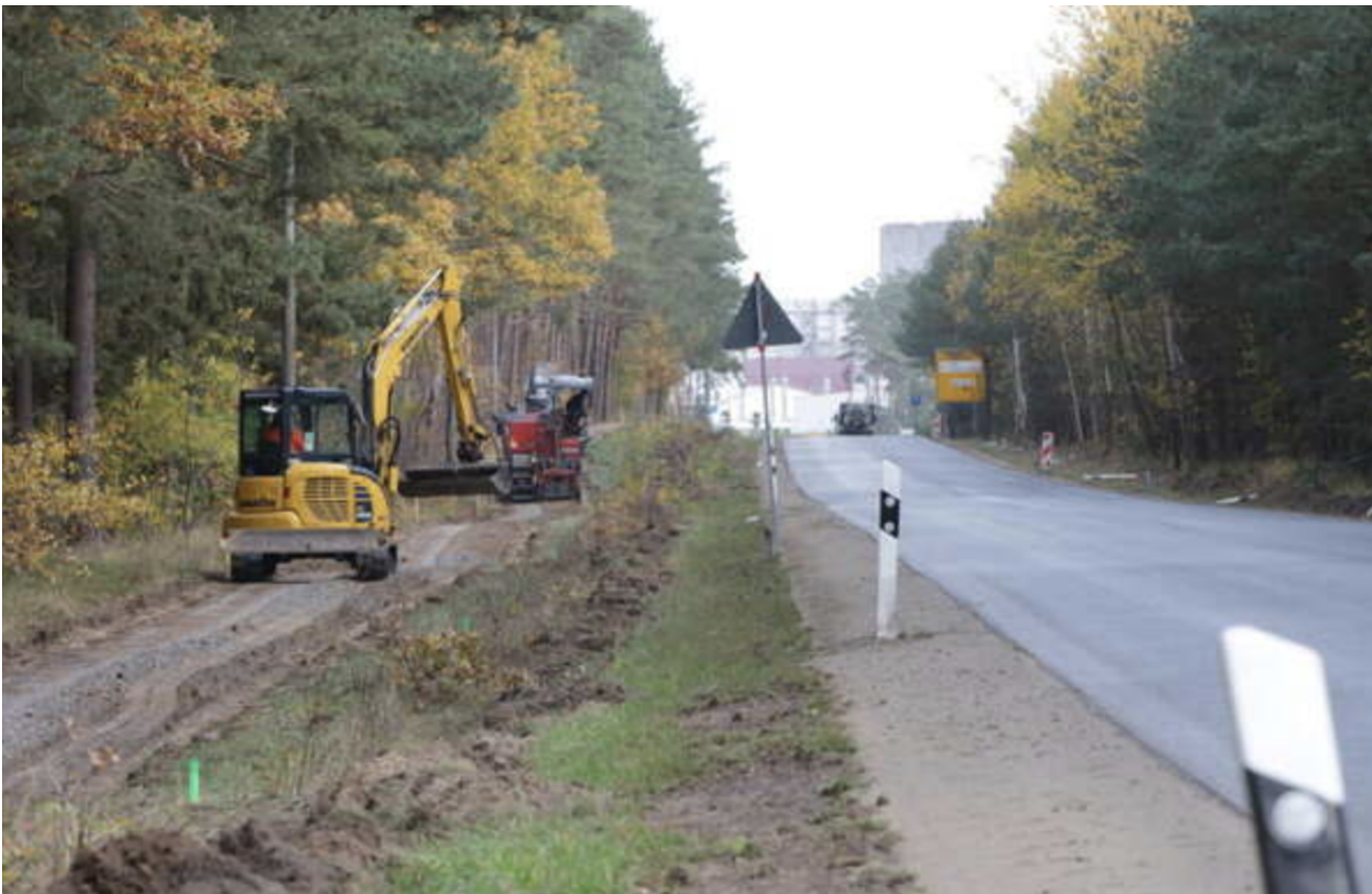
Entlang der Landesstraße Lubmin - EWN entsteht ein neuer Radweg, der Bahnübergang bei Brünzow wird derzeit saniert.
