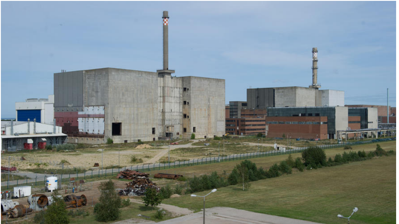
Die Bauruine des Block 8 (I) auf dem ehemaligen Betriebsgelände der „VEB Kernkraftwerke Bruno Leuschner“ in Lubmin, 2015
