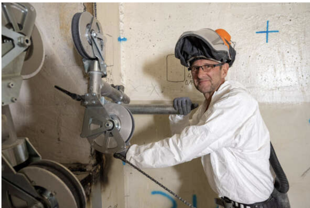
Bildunterschrift: Demontagearbeiter Mario Schmidt richtet eine Seilsäge ein, um Stahlbeton im ehemaligen Kernkraftwerk „Bruno Leuschner“ in Lubmin zu schneiden.
