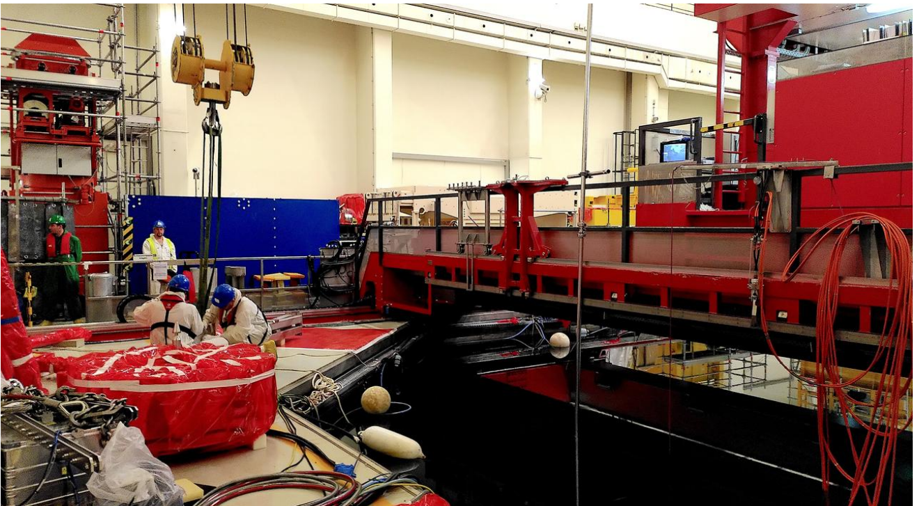
Bildunterschrift: Abgebaut wird von innen nach außen: Seit Jahren sind die Rückbauarbeiten im stillgelegten Atomkraftwerk Brunsbüttel im Gange. - Deutschlandradio / Tom Schimmeck
