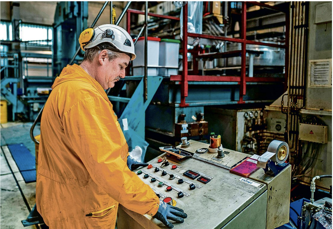
Bildunterschrift: Demontage: Ein Arbeiter im AKW Greifswald bedient die Metallsäge mit der die Werkstücke auf Normgröße zerkleinert werden
