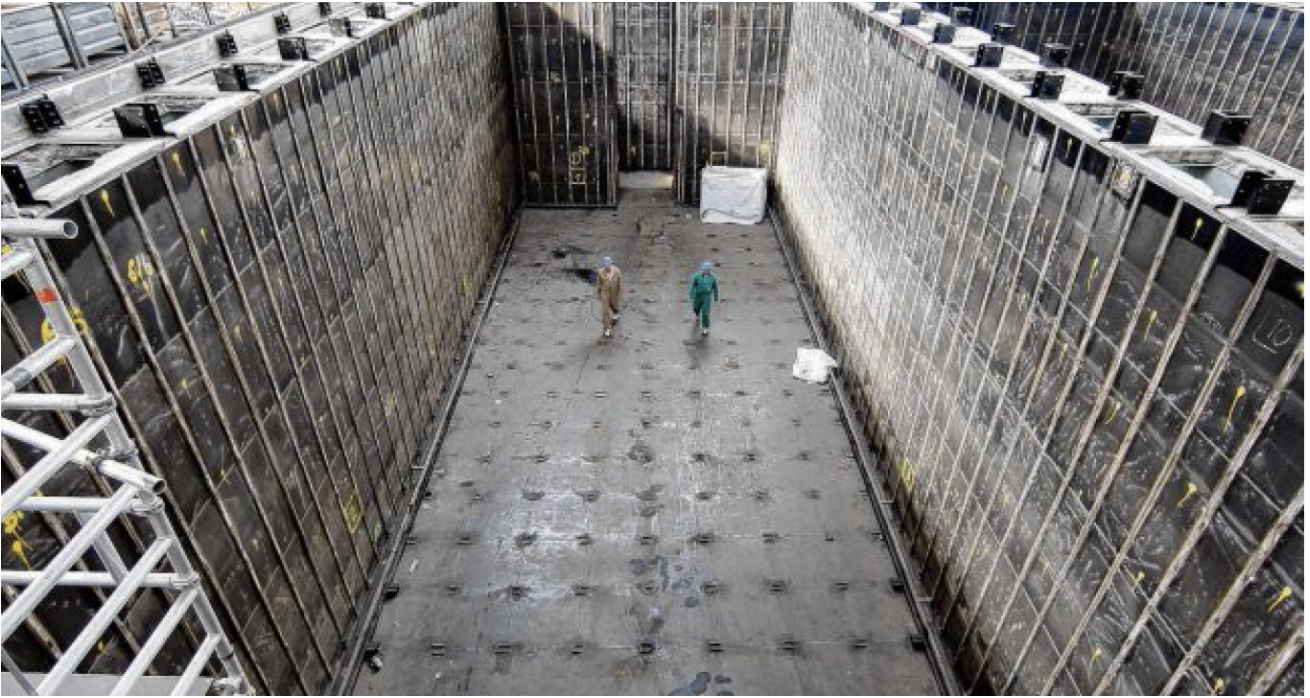
Bildunterschrift: Ein Blick in das längst zurückgebaute Nasslager für verstrahlte Brennelemente – hier eine Aufnahme aus dem Jahr 2009.
