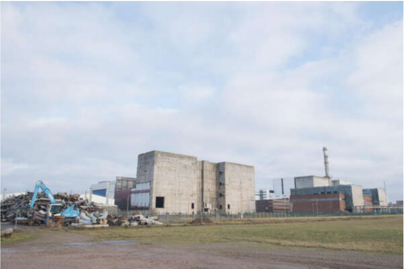
Bildunterschrift: Rückbau des AKW Lubmin
