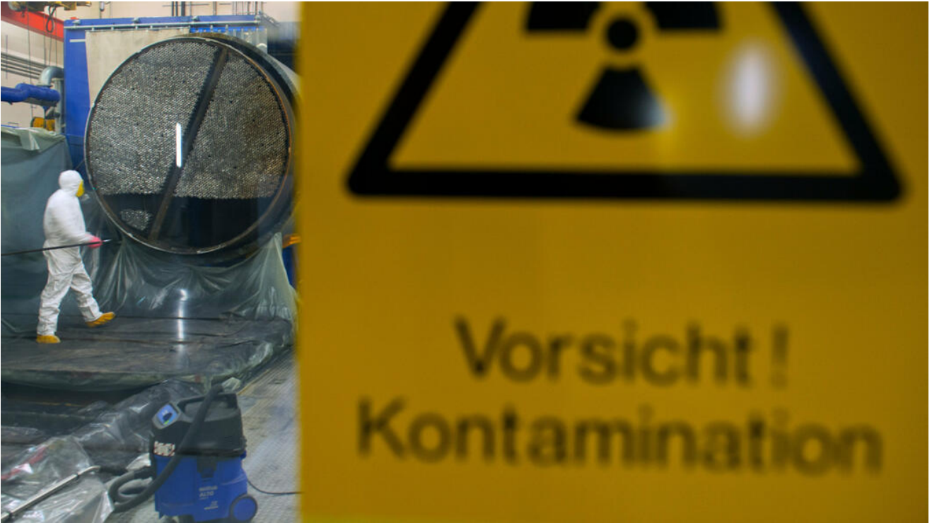
Bildunterschrift: Mitarbeiter des Zwischenlager Nord zerlegen im Zwischenlager Lubmin bei Greifswald einen Dampferzeuger aus dem stillgelegten Atomkraftwerk Obrigheim (Baden-Württemberg). (Archivbild von 2013) Foto: dpa
