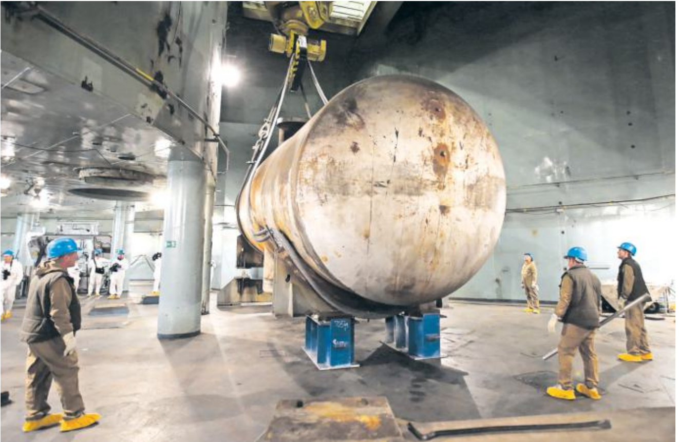
Bildunterschrift: 2013 rücken Arbeiter einem Dampferzeuger zu Leibe – da sollte das ganze AKW Greifswald schon seit fünf Jahren zurückgebaut sein. Foto: Bernd Wüstneck
