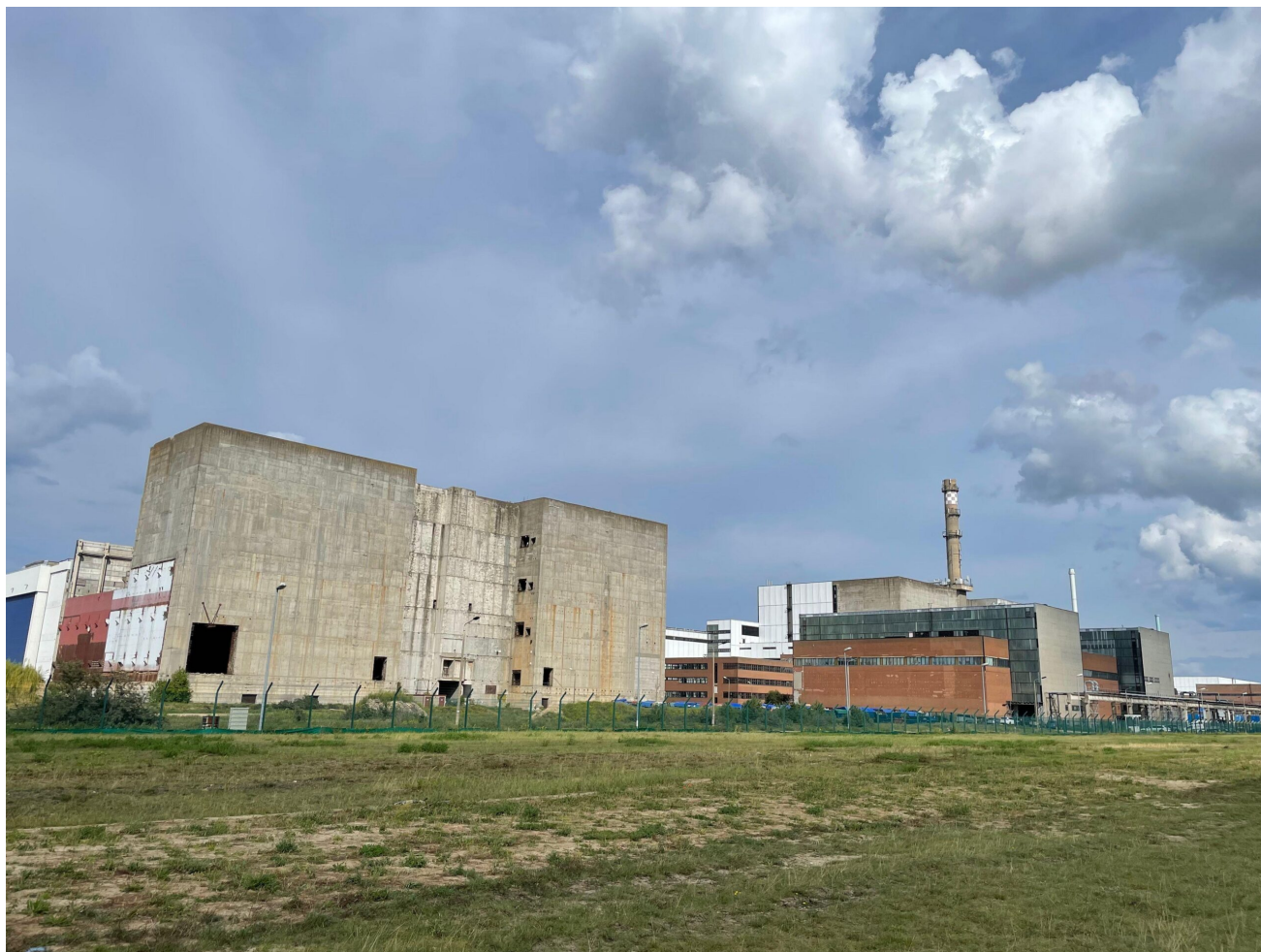
Bildunterschrift: Reaktorblock 6 im Atomkraftwerk Lubmin: Er wurde zwar noch fertiggebaut, ging aber nie in Betrieb.
