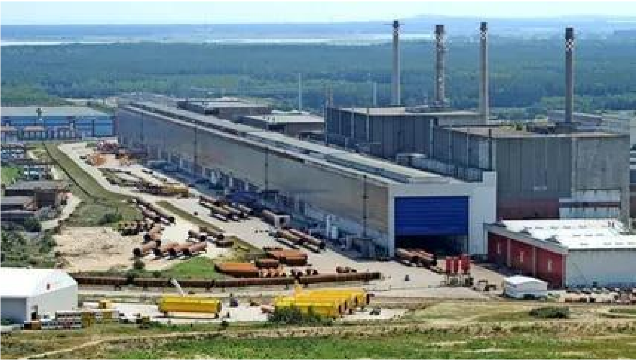
Bildunterschrift: Warnstreiks an Ex-Kernkraftwerks-Standorten in Brandenburg und MV. (Symbolbild: Blick auf das Gelände des stillgelegten KKW Kernkraftwerk Lubmin)
