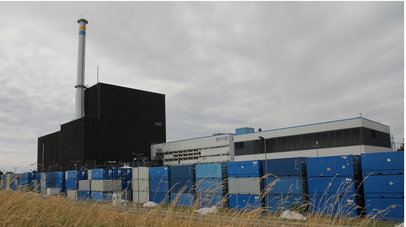
Bildunterschrift: Das Kernkraftwerk Brunsbüttel befindet sich seit 2019 im Rückbau. Im Vordergrund stapeln sich Seecontainer mit eigentlich harmlosem Bauschutt - doch keine Deponie will den haben. - Foto: Marian Schäfer
