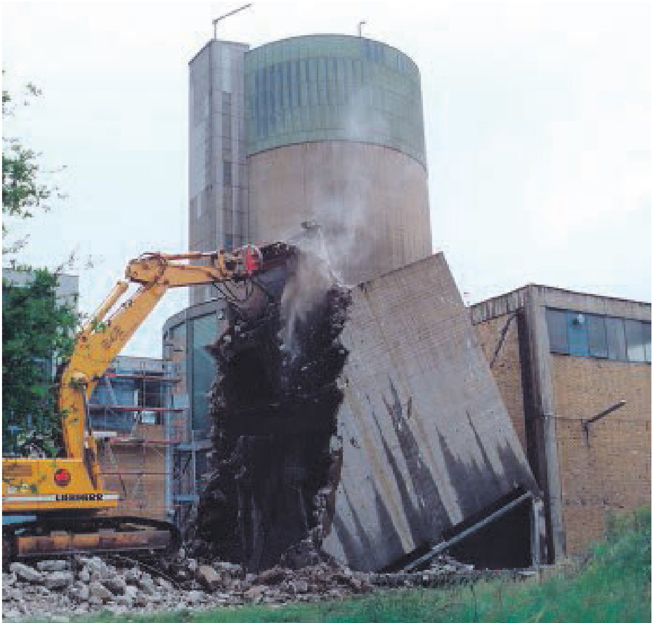
Bildunterschrift: Der Rückbau gestaltete sich schwierig. Mehrfach wurde das Konzept geändert. Nachdem eine Kontamination des Bodens gemessen wurde, einigte man sich schließlich auf das »Konzept der grünen Wiese«. Bild: JEN Jülich
