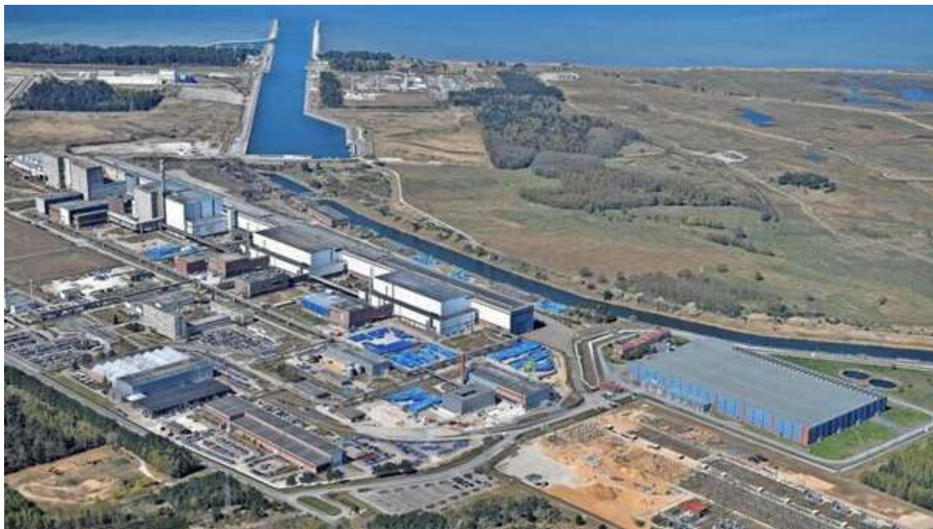
Das Gelände der Lubminer Entsorgungswerk für Nuklearanlagen GmbH ist laut Meinung von Fachleuten der ideale Standort für eine große Wasserstoff-Erzeugungsanlage., Foto: Entsorgungswerk für Nuklearanlagen GmbH
